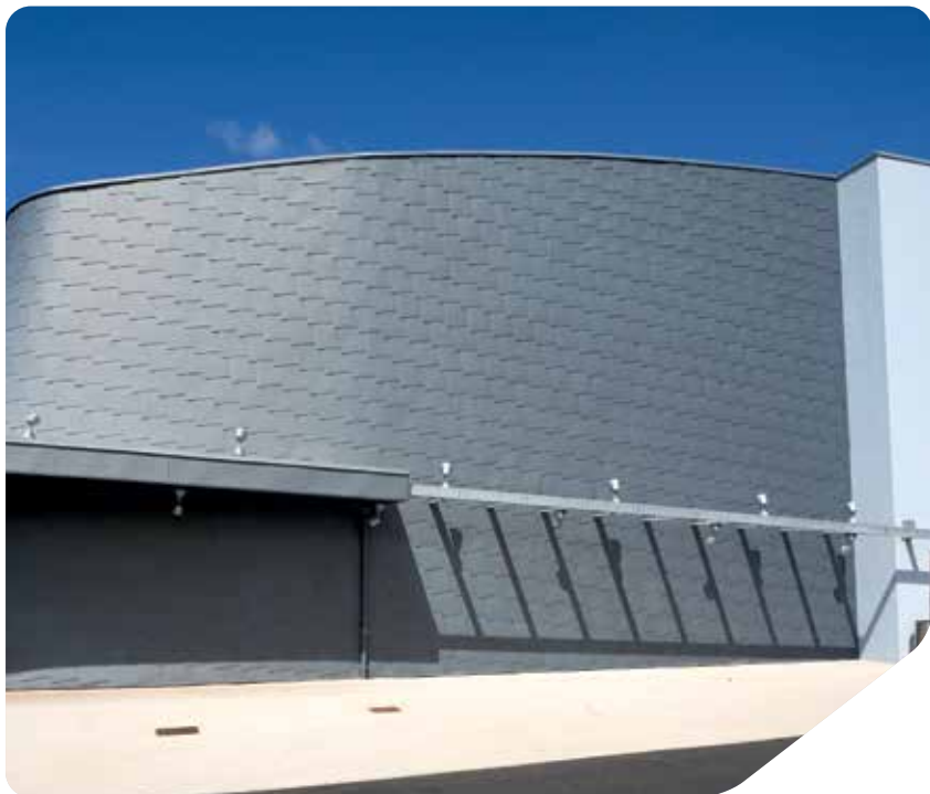
Amfiteater, Pornic (Frankrijk) - Architect: Rachdi-Parent Architectes PIGMENTO® bleu
