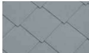
Losanges geplaatst volgens verspringende voegen
