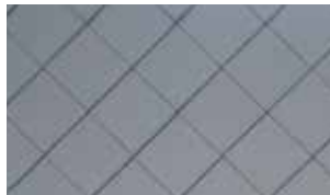
Losanges geplaatst volgens samenvallende voegen
