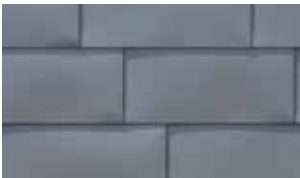
Losanges geplaatst volgens halfsteensverband
