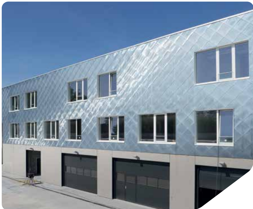
Politiebureau, Eeklo (België) - Architect: SBA Stéphane Beels Architects Natuurlijk zink
